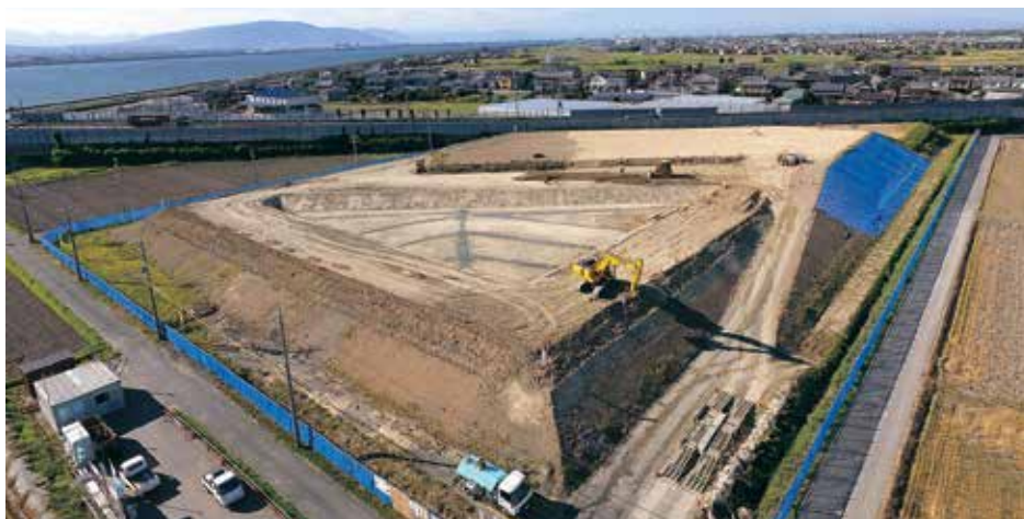
現場全景（ドローンによる撮影）
