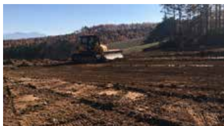
ICTブルドーザD65PXiで整地
