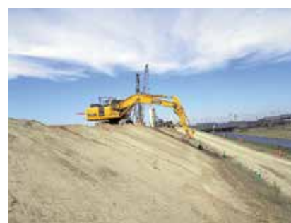
ICT油圧ショベルPC200iで法面作業
