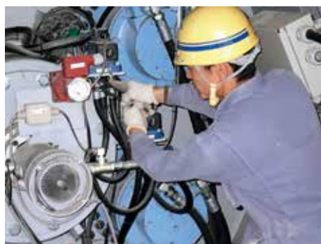
シールド掘進機等特殊機械組立作業
